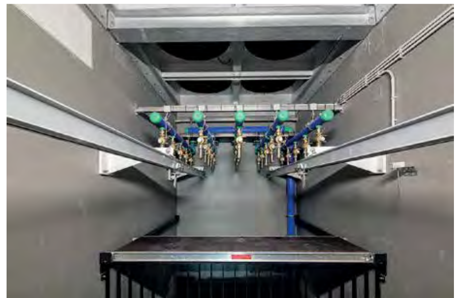
De Klimaatcascade is een schacht waarin van bovenaf waterdruppels worden gespreid, waarmee de lucht kan worden gekoeld of verwarmd. Foto: Eric Fecken
