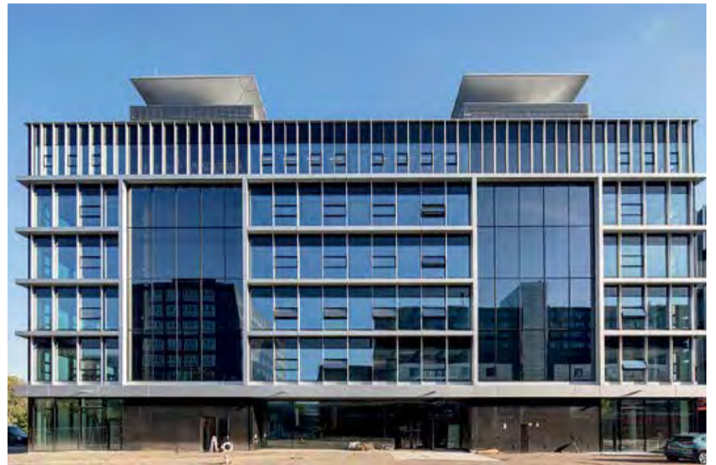
Het EWF-concept is toegepast bij een onderwijsgebouw van de Erasmus Universiteit in Rotterdam. Daarnaast is het mogelijk EWF toe te passen bij bestaande hoogbouw. Foto: Eric Fecken
